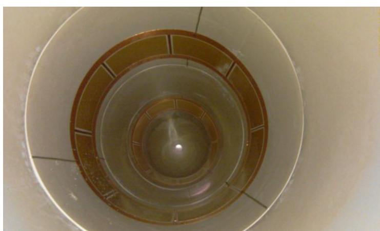
Rysunek. Widok wnętrza silosu z rozmieszczonymi czujnikami ECT.
